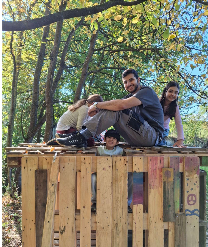
Abb. 15: Das Erdgeschoss der Hütte steht!
